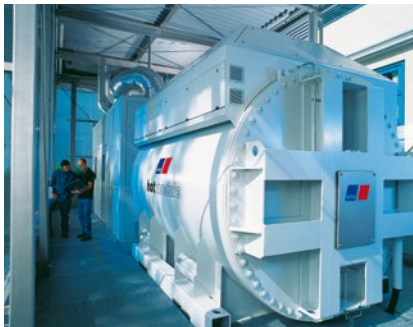
Fig. 9 | HotModule (MTU Friedrichshafen)
